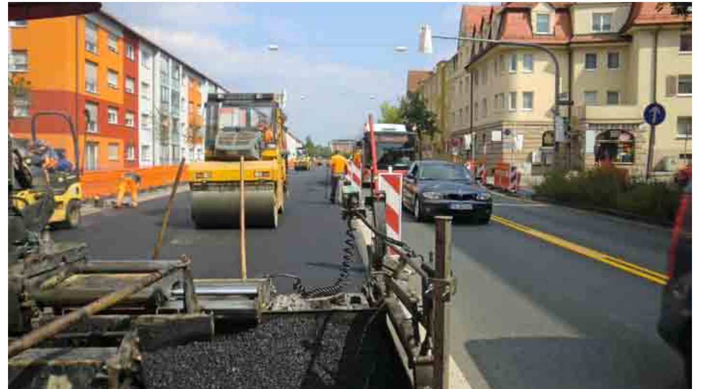
Einbau in der Frankenstraße
