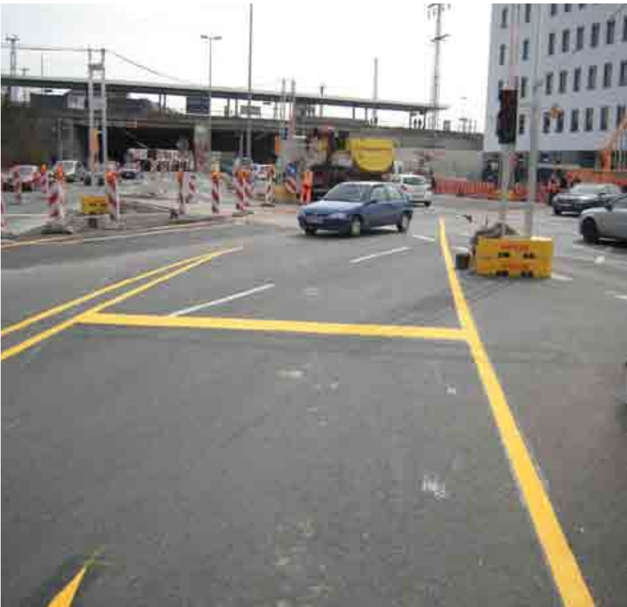
Baustellenabsperungen und mobile LSA während des Umbaus
