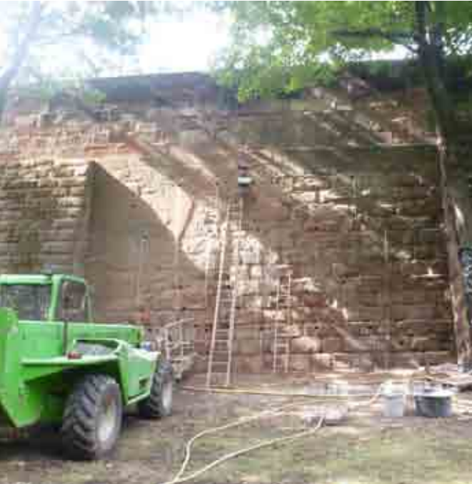
Danach werden die zur Rückverankerung nötigen Bohrlöcher verpresst
