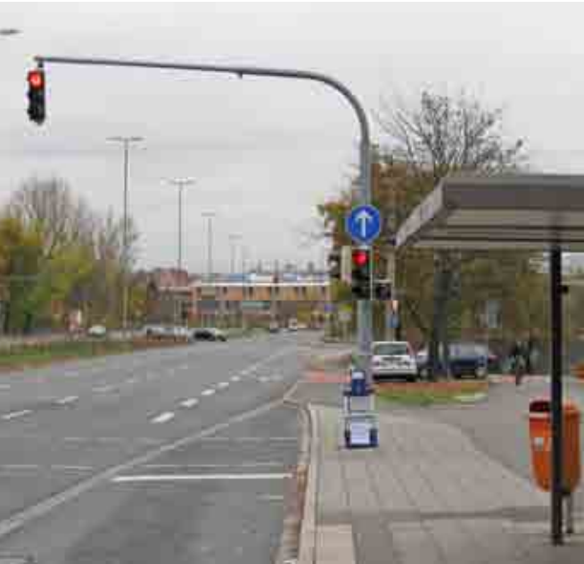
Endzustand Bahnhofstraße/Dürrenhofstraße: neue LSA
