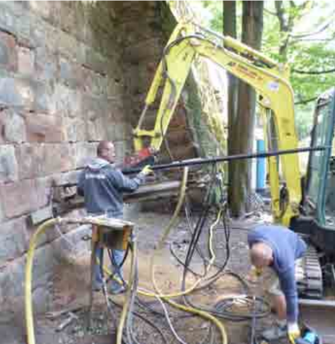
So werden die Nägel angebracht, um die Stadtmauer zu stabilisieren
